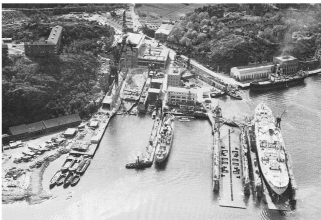
Figur 2-4 Finnboda varv var under tidigt 1950-talet Sveriges näst största varv. Hästholmssundet skymtas till vänster i bild och Finnberget syns bakom varvet. Källa!
